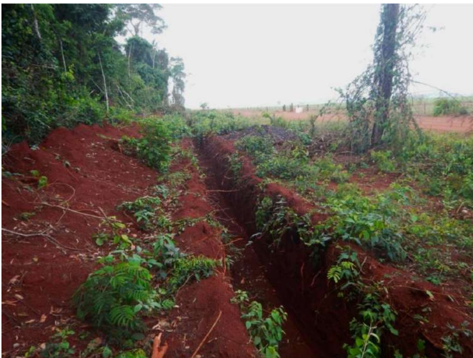
Figura 53: Vala com mais de 2m de profundidade a noroeste da TI Tanaru. Fonte: Amanda Villa [set/2023].
